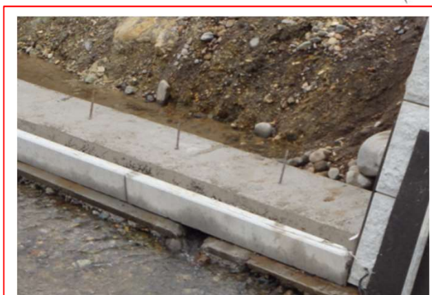
調整（高さ）コンは下部に設置
