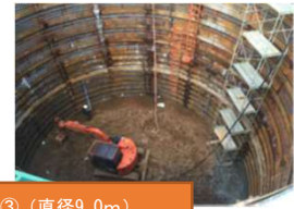
大型井戸③ (直径9.0m) ライナープレート (地中に埋戻し済、現在更地)
