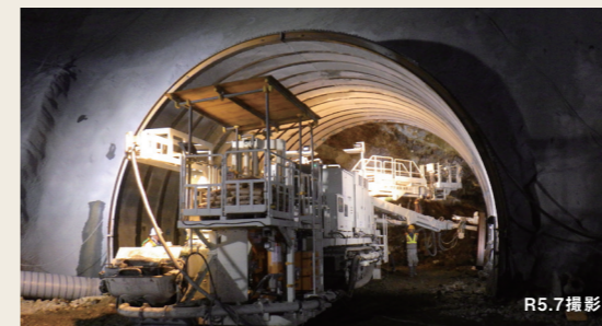
トンネル掘削の作業状況
