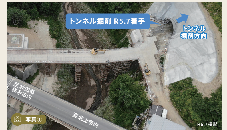
西和賀側(終点側)の状況
