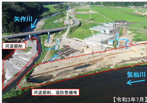
【河道掘削、堤防整備（気仙川） 越戸内地区】
