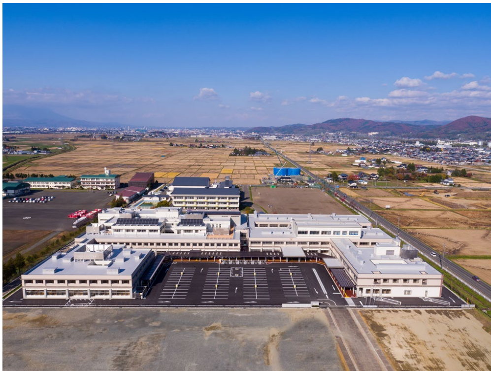
【整備後の外観】
