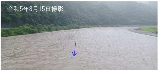
赤鹿橋水位局地点での観測水位から改修前断面での水位を計算したところ、**21cmの水位低減効果**があった。
