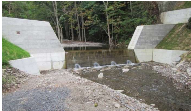
令和4年度完成 戸塚地区 治山ダム
