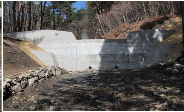
令和4年度完成 四十八坂地区 治山ダム
