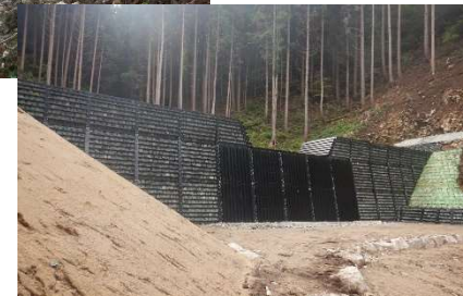
【治山工事施行後 白浜】
