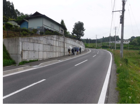
写真① (整備後)
