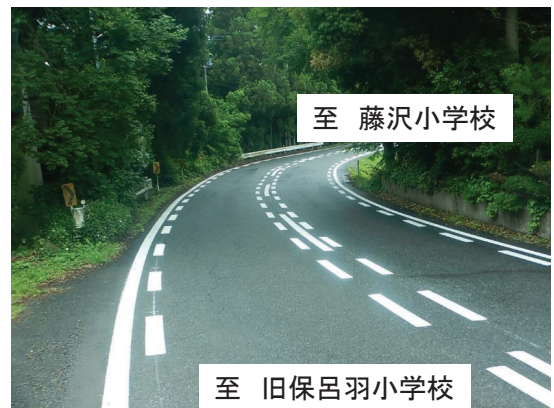
路面標示整備後
