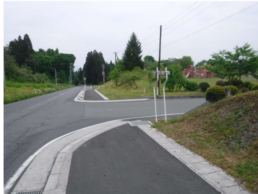
写真② (整備後)
