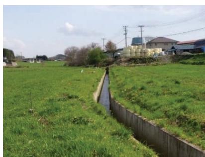
写真:排水路(整備後)
