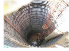
大型井戸④ (直径3.5m) ライナープレート (地中に埋戻し済、現在更地)
