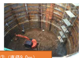
大型井戸③ (直径9.0m) ライナープレート (地中に埋戻し済、現在更地)
