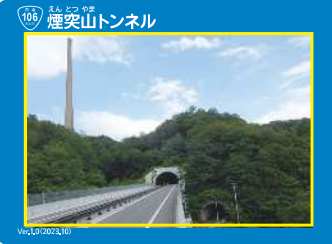
▲①煙突山トンネル
