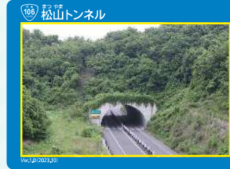
▲③松山トンネル
