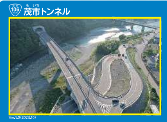
▲⑥茂市トンネル
