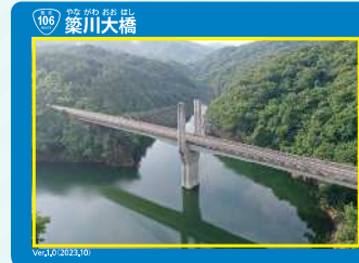
▲⑫築川大橋
