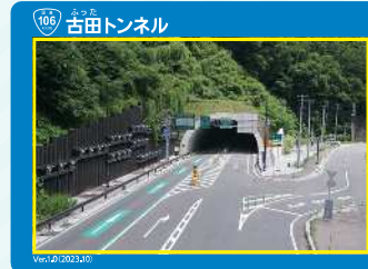
▲⑧古田トンネル
