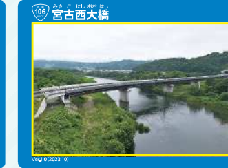
▲⑤宮古西大橋
