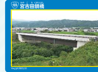
▲④宮古田鎖橋
