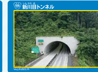
▲⑮新川目トンネル
