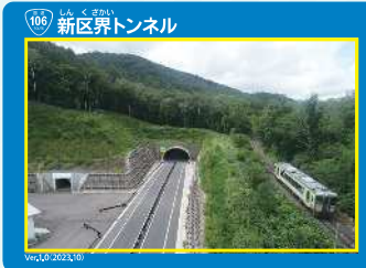
▲⑪新区界トンネル
