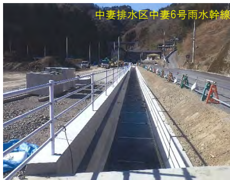
暗渠を開渠化
