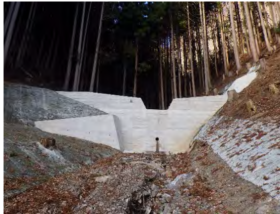
令和元年完成 釜石市駒木地区
