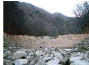
【治山:溪間工(治山ダム)】
