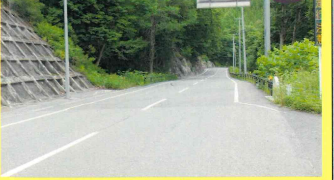
住田町世田米地内子飼沢トンネルから栗木トンネル間の線形改良
