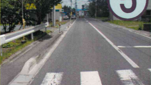
胆沢南都田字本木地内の歩道拡幅
