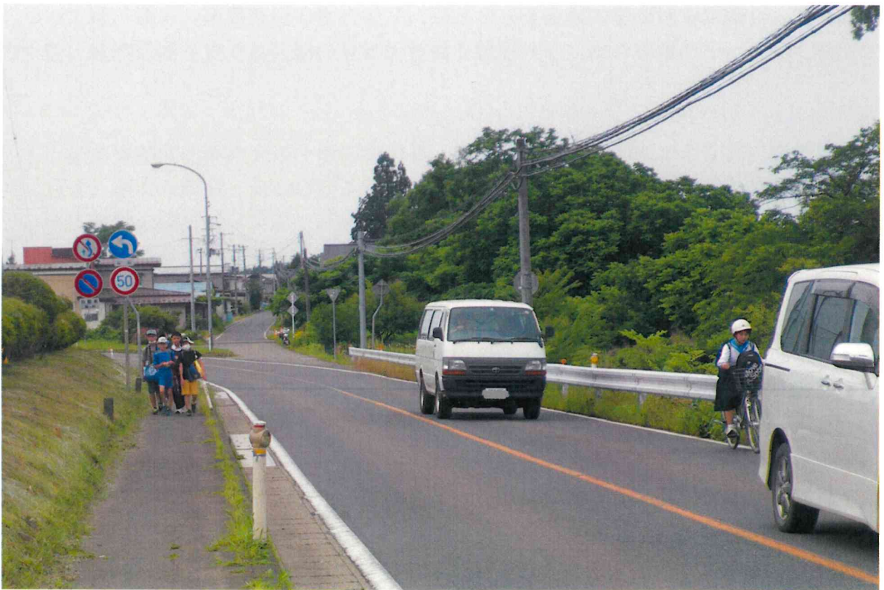
【犬吠森地内の車道・歩道拡幅の整備促進（紫波東学園付近）】
