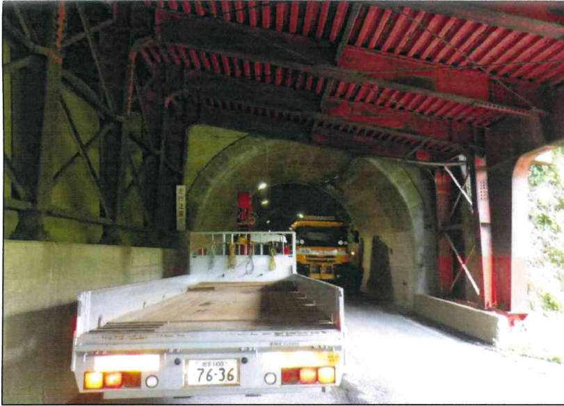
箇所④ 大荒沢トンネル(西和賀側入口)
