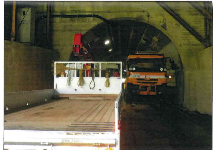
箇所④ 大荒沢トンネル(北上側入口)
