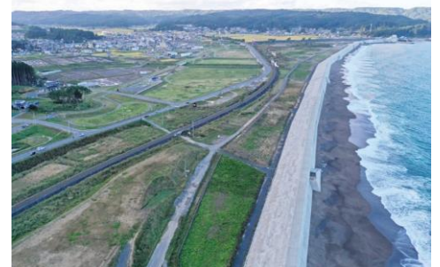
〔野田村前浜地区防潮堤〕
