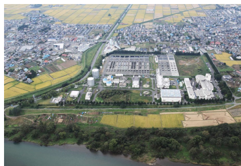
都南浄化センター
