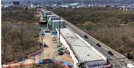
渋滞を緩和する道路の整備(杜の大橋)
