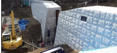
土石流の被害軽減のための堰堤整備 (尾崎白浜の沢(4))
