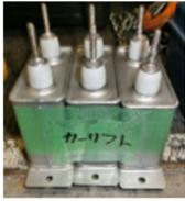
昇降機の定期点検時にメンテナンス業者等に依頼してコンデンサーの銘板から製造年を確認。
