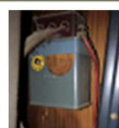
配電盤に設置された低圧コンデンサー
