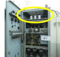
可変周波数電源装置の低圧コンデンサー
