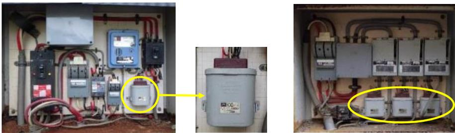
分電盤に設置された低圧コンデンサー
