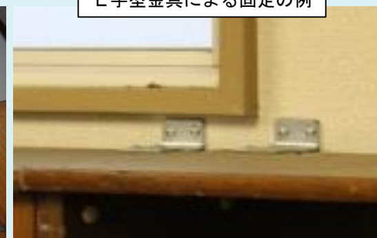
L字型金具による固定の例
