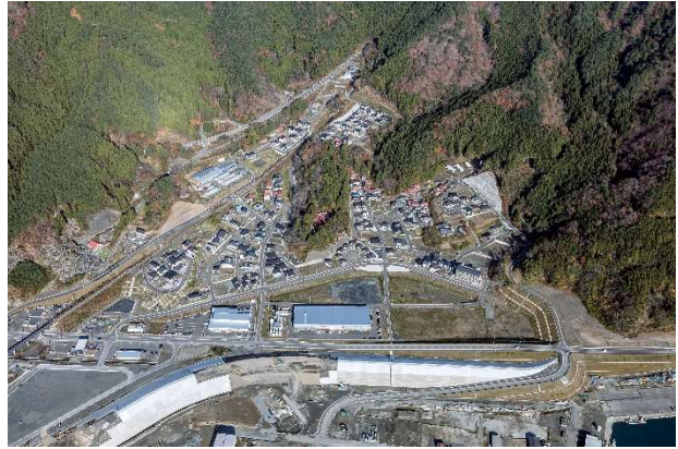
■整備後の状況（H29.11.26 撮影）
