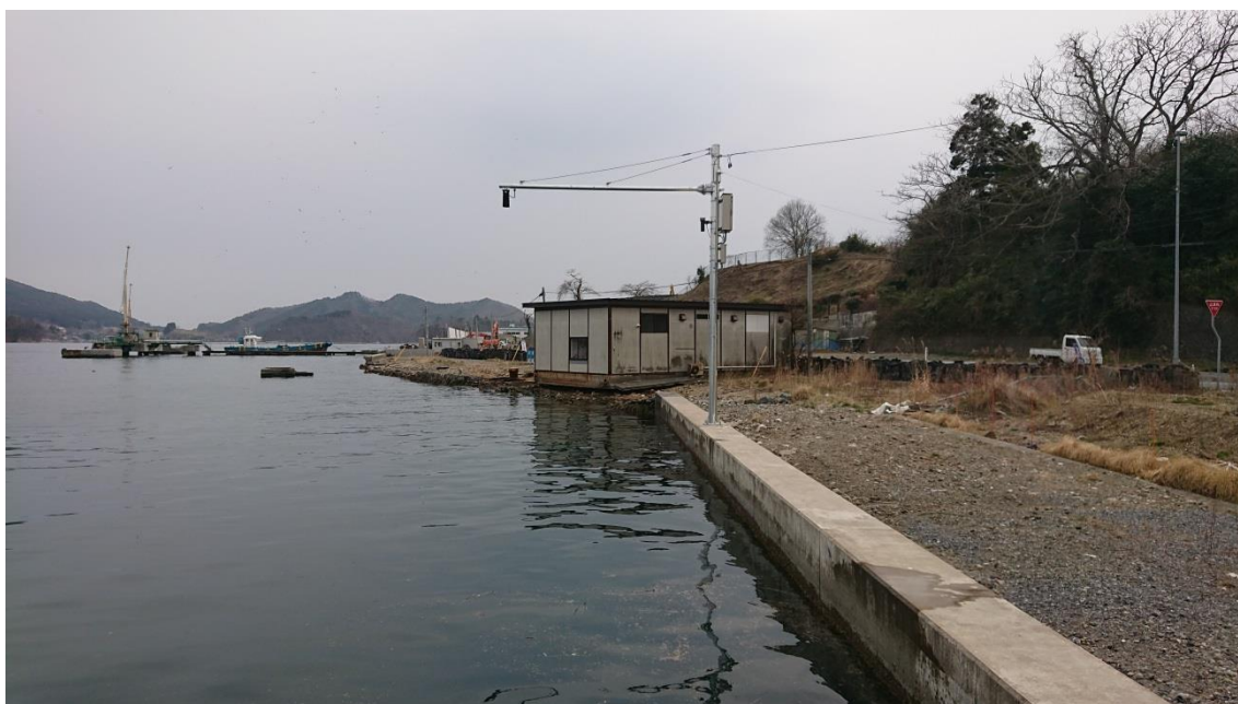
【潮位観測システム観測局】
