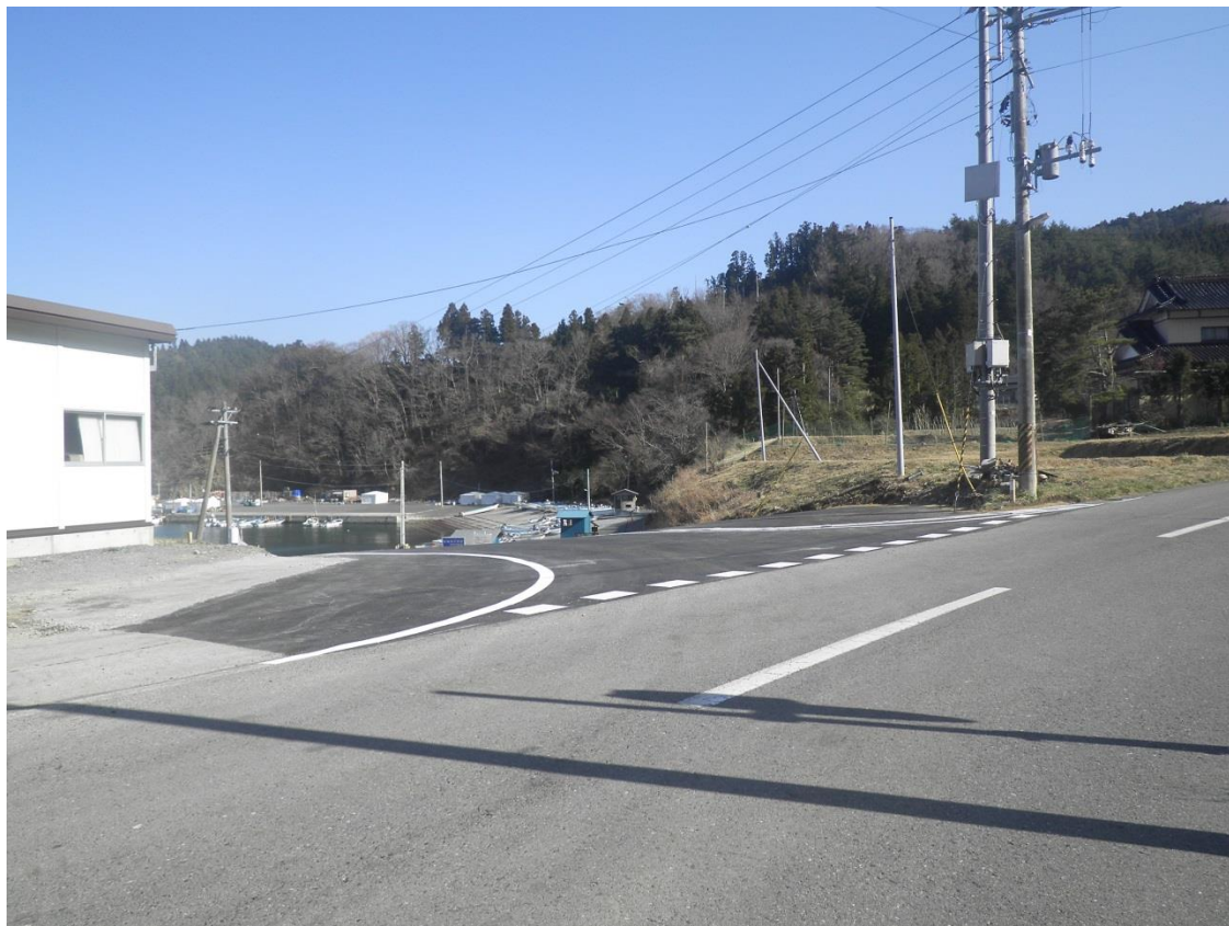
避難路整備 完了状況
