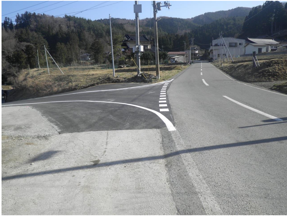
避難路整備 完了状況
