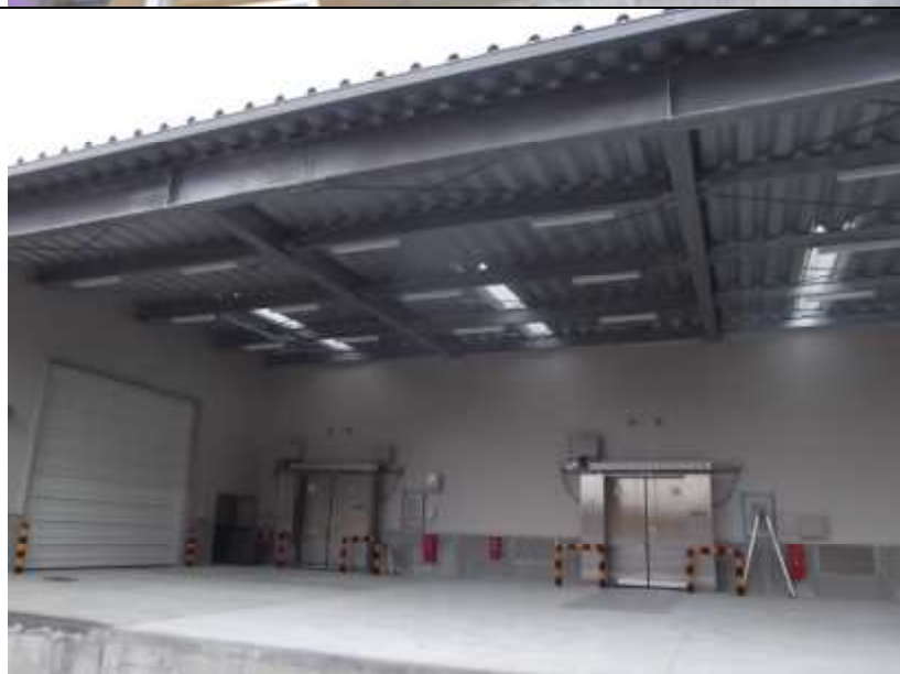
株式会社かわむら (2回目) 倉庫、冷蔵庫 No. 1 及び 2 入口
