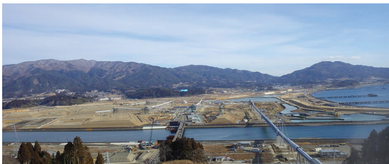
（今泉地区からベルトコンベアで土砂を運ぶ様子）
