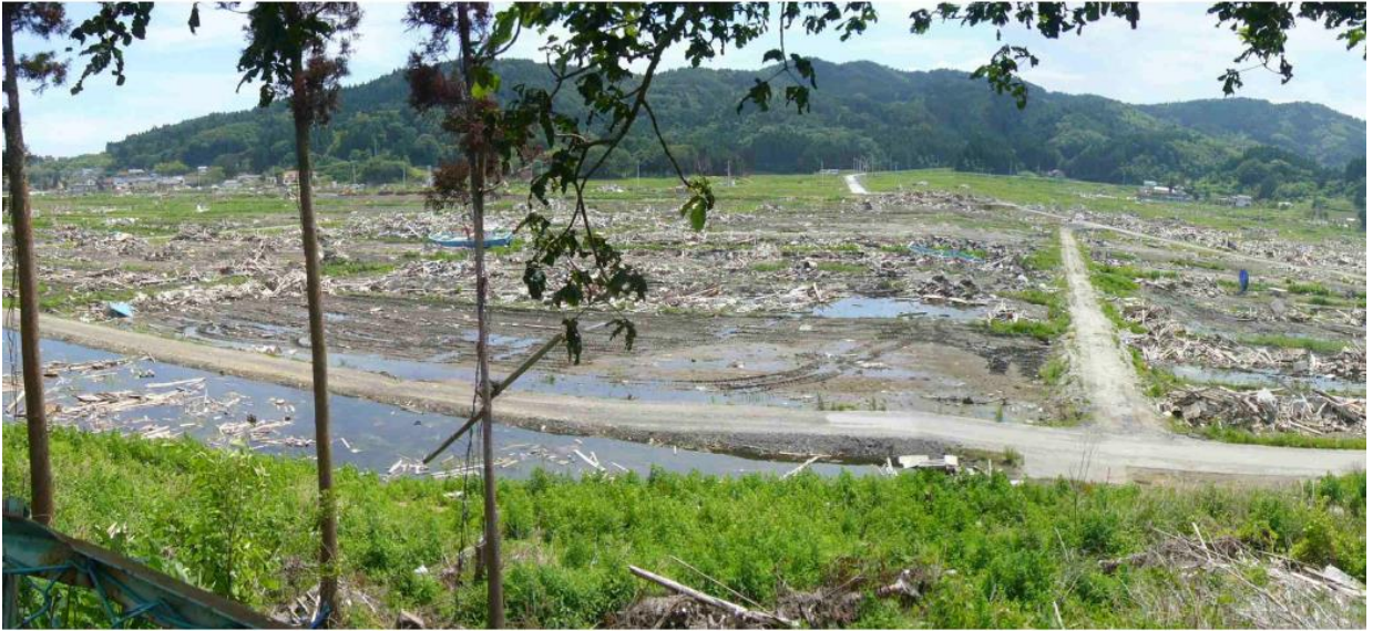
【整備前の被災状況】
