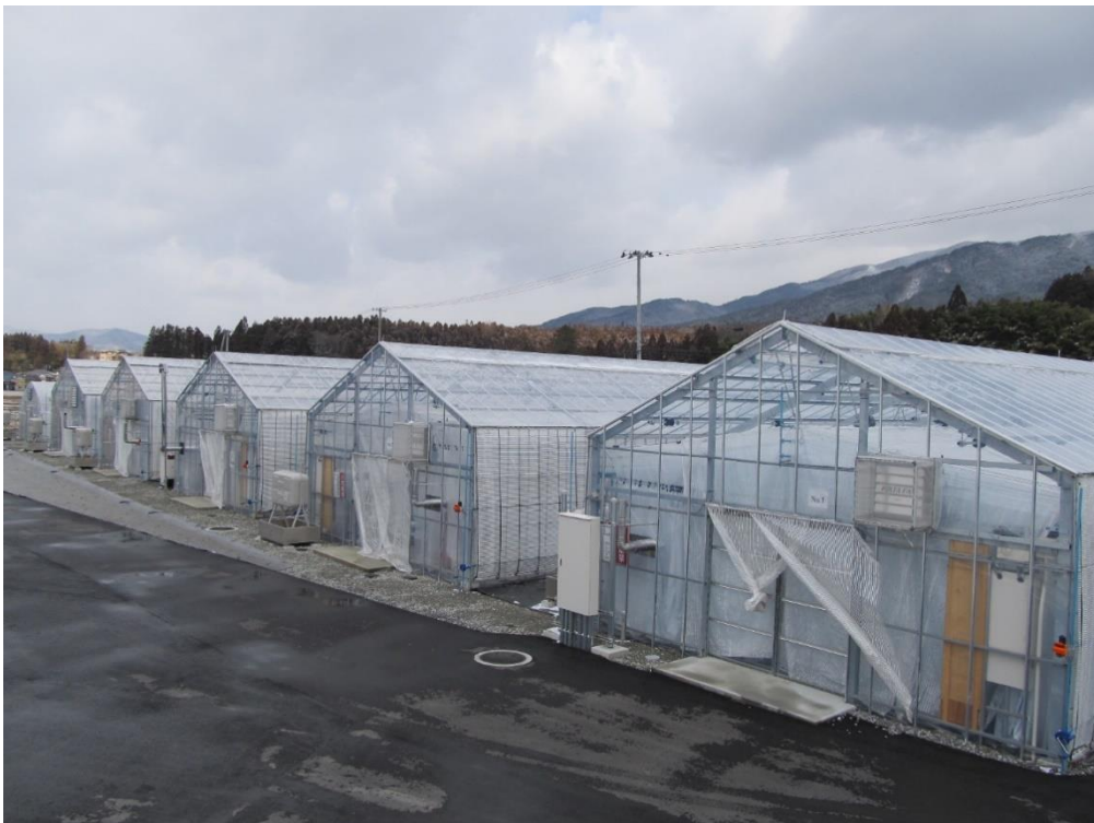
【整備後（軽量鉄骨ハウス・パイプハウス）】
