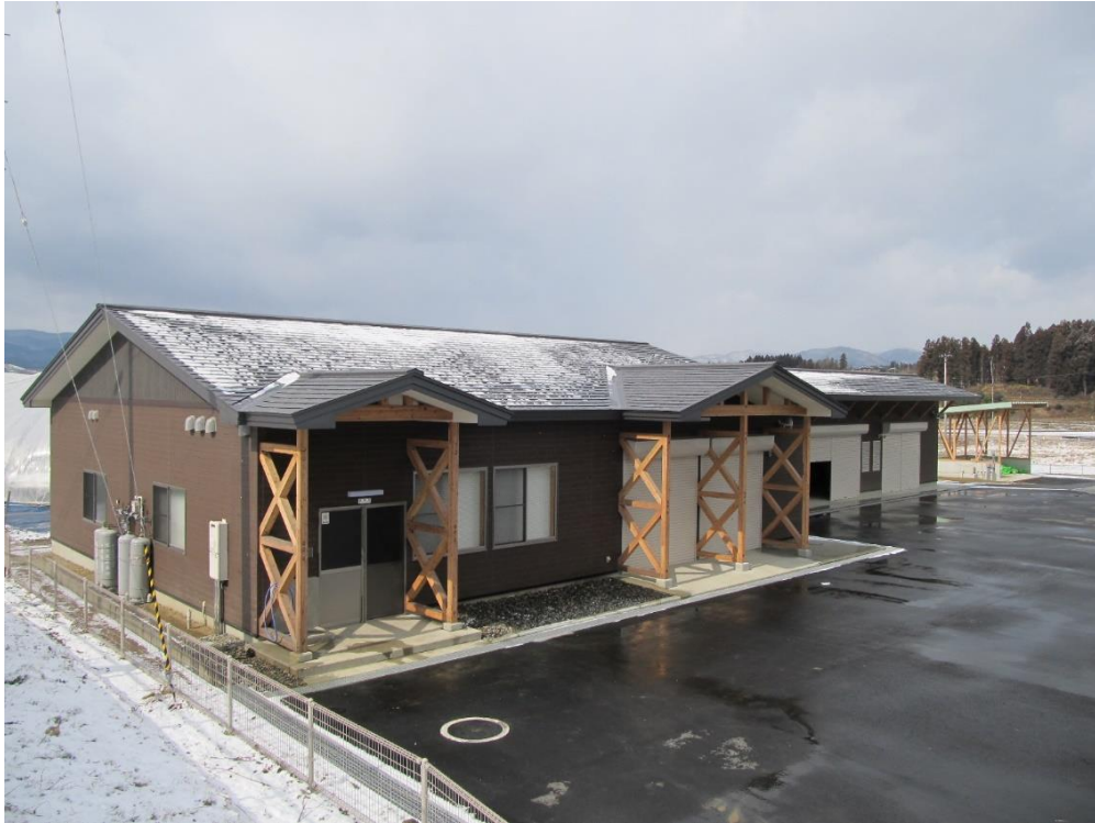
【整備後（ほ場管理棟）】
