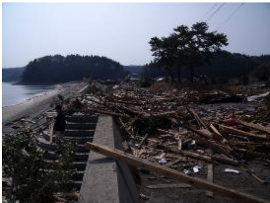
【整備前の旧県道の被災状況】
