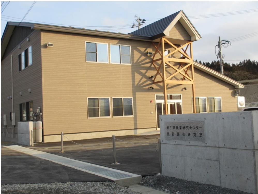
【整備後（南部園芸研究室本館）】
