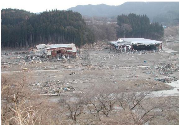
【整備前の旧県道の被災状況】
