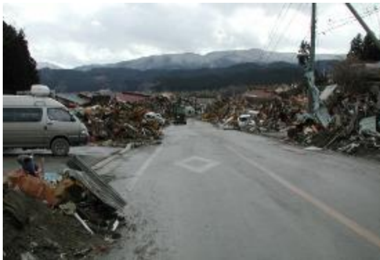
【整備前の旧県道の被災状況】
