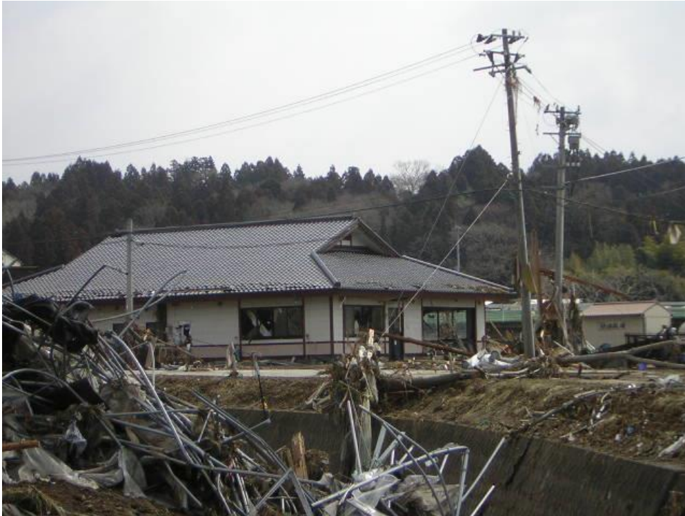
【被災状況（研究室本館）】
