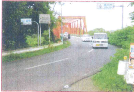
金ヶ崎橋付近 歩道がないことから危険な状況
