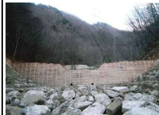
【治山: 溪間工(治山ダム)】
