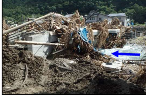
①中の橋の流木閉塞状況
