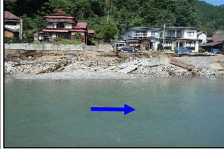
②左岸側の溢水被災状況
