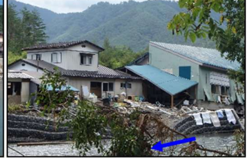
③右岸側の溢水被災状況
