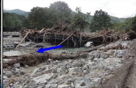
⑥安家橋の流木閉塞状況
