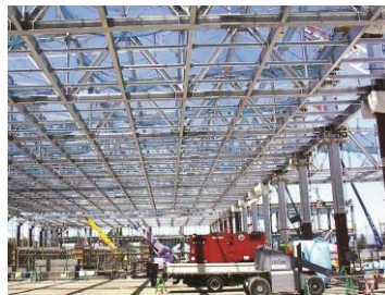
工場建屋 梁・柱
