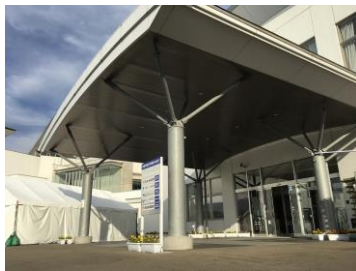
花巻総合体育館 玄関柱
