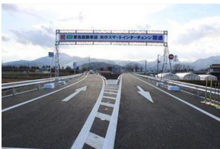
東北自動車道矢巾スマートインター チェンジ舗装工事
