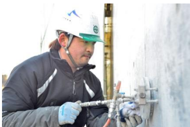
ひび割れ補修工事
