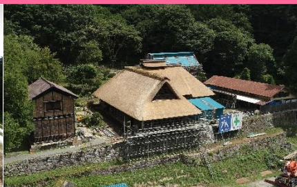
千葉家改修工事
