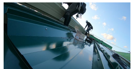
〔屋根を葺く作業〕
