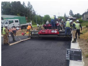
アスファルトの舗装
