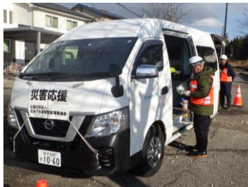
マンホール管路調査
