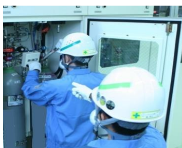
ガスポンベ交換作業
