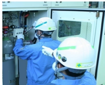
ガスポンベ交換作業
