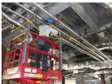
〔建設現場：配管作業〕
