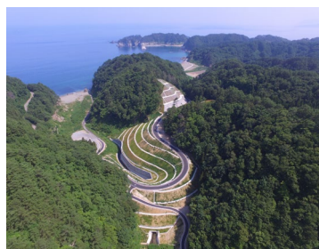
沼の浜地区道路災害復旧工事
