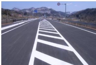
一般県道折壁大原線大原地区 道路改良舗装工事
