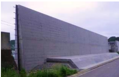
広田漁港海岸災害復旧 (23 災県第 522 号防潮堤その 2) 工事
