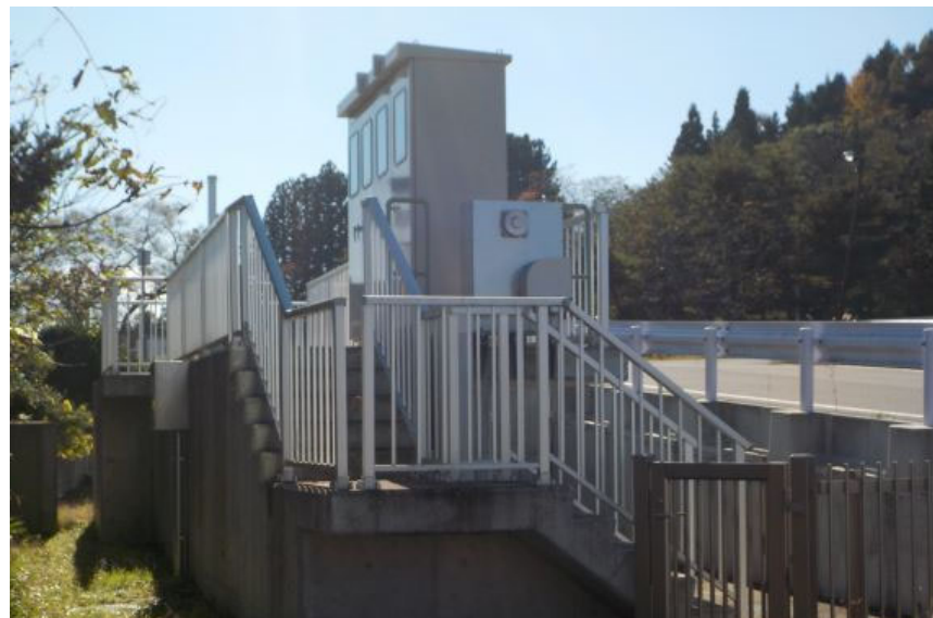
宇部川第3排水区ポンプ場
