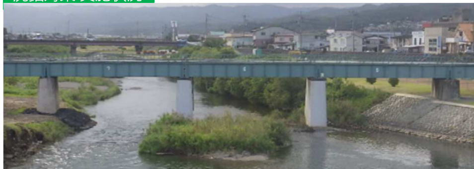
洗掘対策前(久慈川下流側より)
