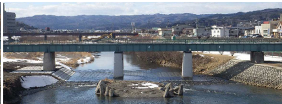
洗掘対策後(久慈川下流側より)
