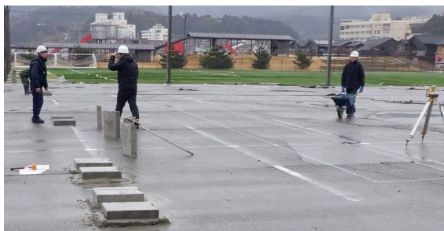
現地での調査・検査の状況
