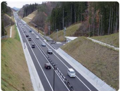
三陸沿岸道路
