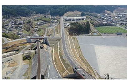
(主)大船渡綾里三陸線 赤崎工区 (まちづくり連携道路)
