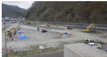
太田名部漁港 臨港道路の整備
