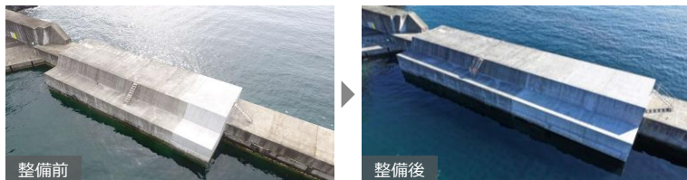
(両石漁港) 防波堤
