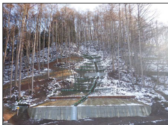
山腹崩壊箇所の復旧整備
