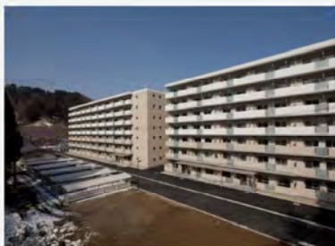
東近平田アパート(盛岡市) 東日本大震災後、岩手県で最初に着工した災害公営住宅
