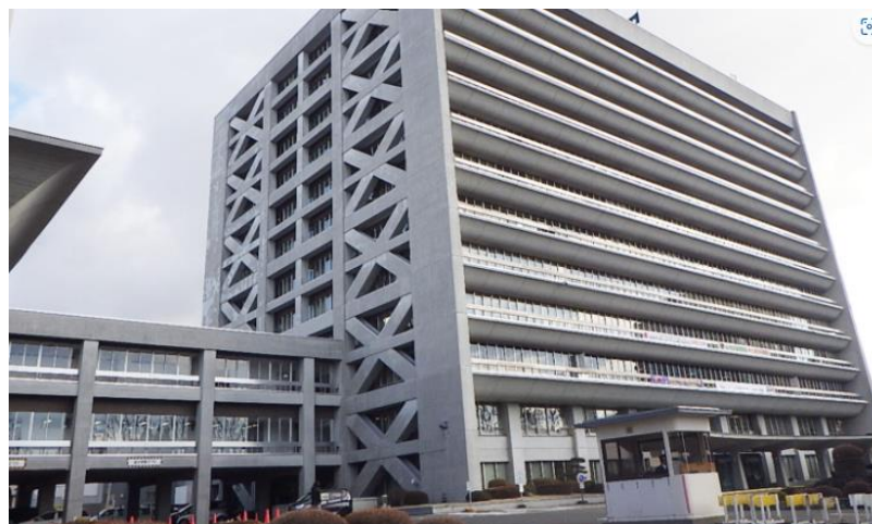
岩手県庁舎知事局棟外壁等修繕工事
