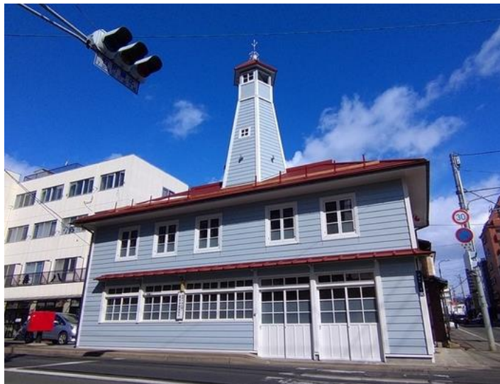
紺屋町番屋の改修工事
