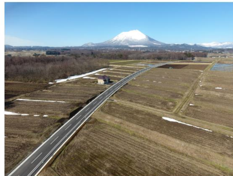
市道下田生出線（下田工区） 道路改良工事及び配水管布設工事
