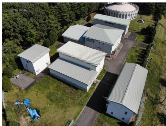
金ヶ崎ろ過施設
