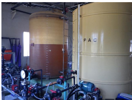
第二浄水場薬品貯留槽
