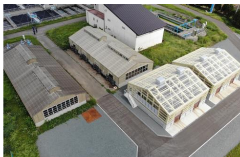
第二浄水場 天日乾燥床
