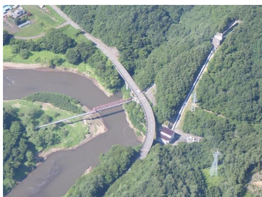
北上川を横断する農業用水管（左）と 岩洞第二発電所へ導水する水圧鉄管（右）
