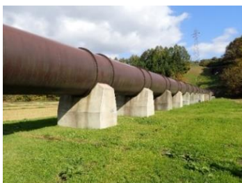
岩洞第二発電所濁川サイフォン
