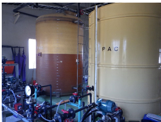
第二浄水場薬品貯留槽
