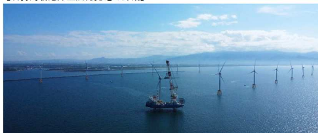
【石狩湾新港洋上風力発電の外観】
