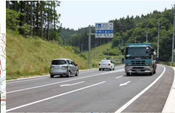
平成30年に開通した「室根バイパス」
