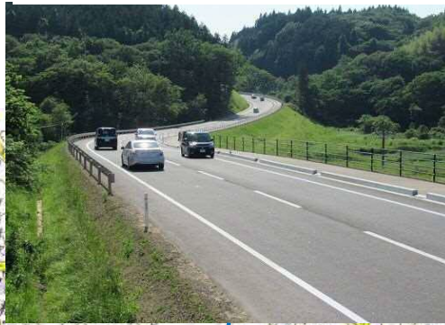
令和3年1月に開通した石法華地区
