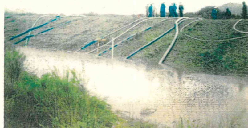
地元業者による排水
