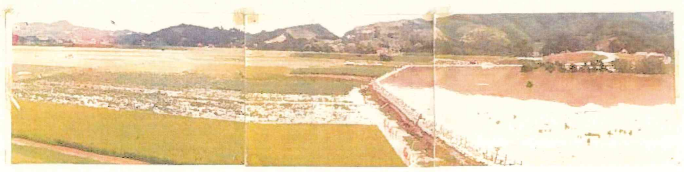
北上川堤防からの全景
